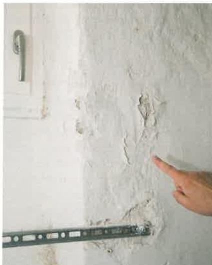
Rückblick: Nach der ersten falsch durchgeführten Sanierung löste sich der Putz wieder ab.
