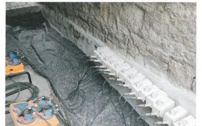
Im nächsten Schritt werden alle Bohrlöcher für die Sperrschicht mit beheizten Vorratsbehältern für das Paraffin vorbereitet, die ein Regler auf konstanter Temperatur hält.
