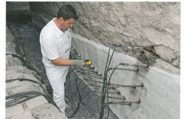
Nach dem Aussagen der Bohrlöcher erfolgte die kontrollierte Trocknung des Wandabschnitts mit speziellen Heizstäben und einer Temperatur von ca. 100 °C.
