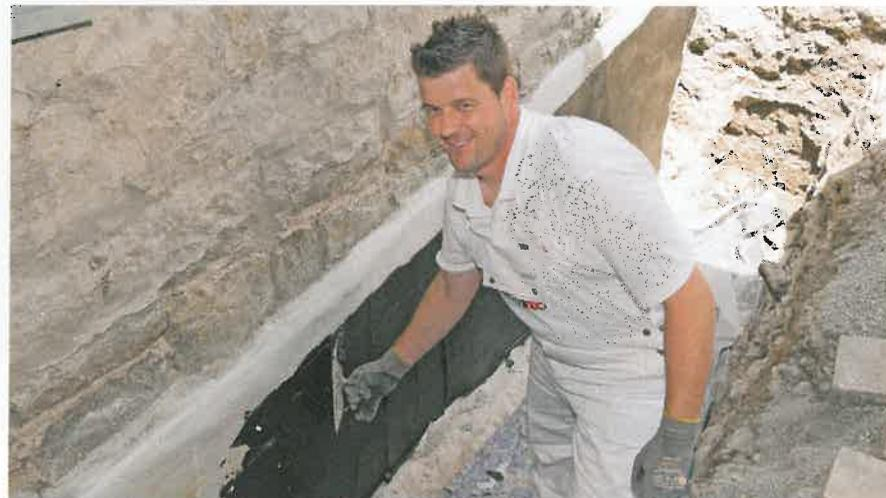
Die kunststoffmodifizierte Bitumdickbeschichtung (KMB) von Isotec ist wasserundurchlässig, flexibel und rissüberbrückend. Eine Gewebeeinlage verstärkt die Abdichtung zusätzlich.
