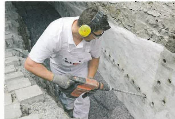
Nach der Freilegung der betroffenen Kellerwände des Hanghauses wurde im ersten Schritt eine Reihe von Bohrlöchern im Abstand von etwa 10–12 cm angelegt.
