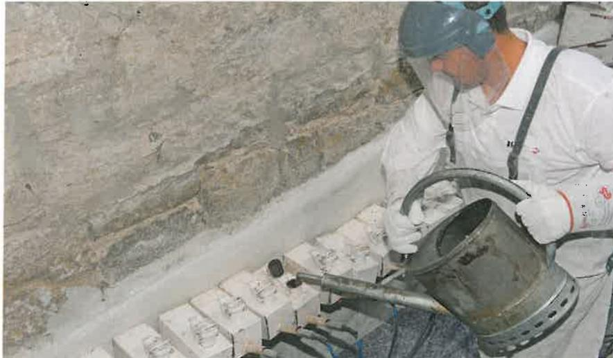
Das erhitzte Paraffin wird eingefüllt und vom Mauerwerk durch die Kapillarwirkung eingesogen. Anschließend härtet es bei der Abkühlphase aus und bildet die horizontale Sperrschicht.
